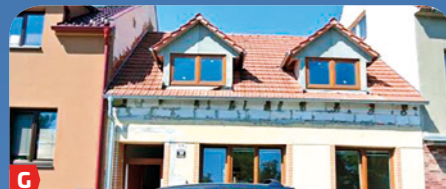
DŮM, BRNO, OPTÁTOVA Prodej RD 5+1 se zahradou a dvorem o CP 305 m 2 , se započatou nástavbou. Za domem dvůr s dílnou a kůlnou. 5 790 000 Kč | 777 555 920
