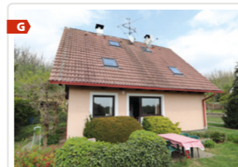
Rodinný dům, Němčičky • samostatně stojící rodinný dům 5+kk s garáží pro dvě auta • součástí domu je vedlejší stavba s bytem 2+1 se zimní zahradou • prostorný a částečně podsklepený dům je ve velmi dobrém stavu a náleží k němu pozemek 6 391 m 2 vč. části lesa N/RSB/17818/19 5 990 000 Kč
